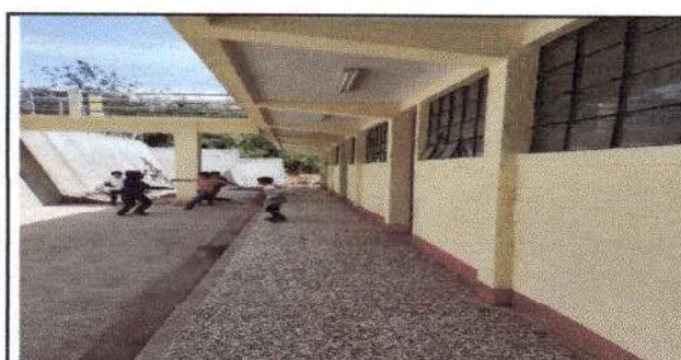
Foto 6: Pintura en muros, interiores y exteriores
