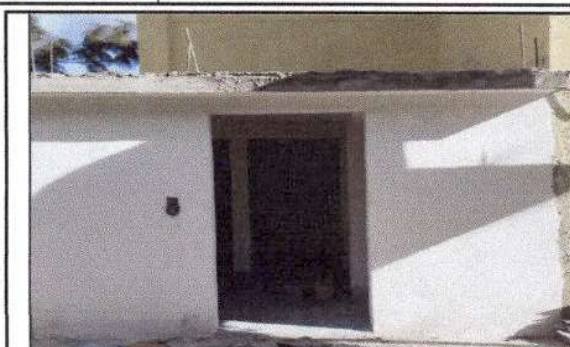
Foto 2: Sustitución de piso o torta de concreto
