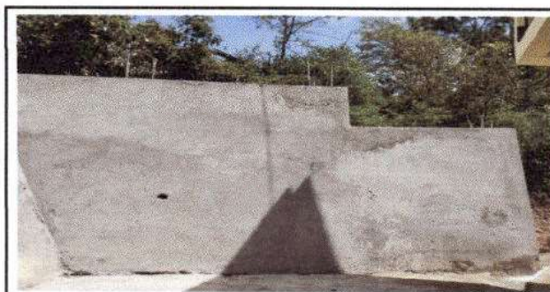
Foto 4: Reparación de muro de Contención.
